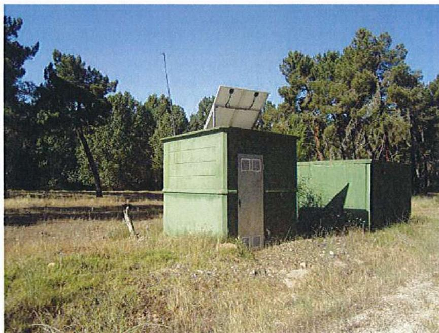
Imagen 10 Arqueta con elementos de telecontrol en conducción de recarga
