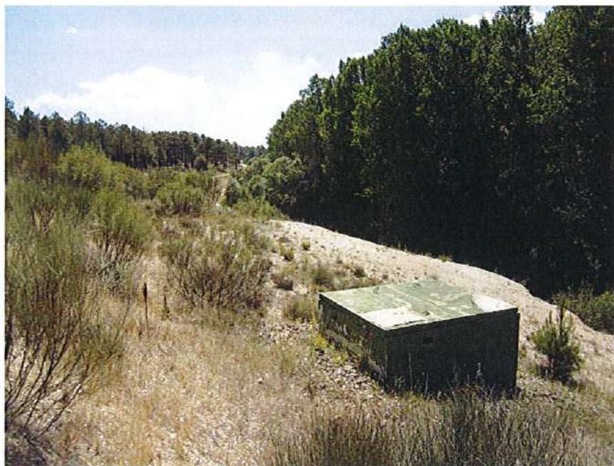
Imagen 9 Arqueta conducción PRFV Ø 1.200 C.R Carracillo, m.d. río Cega
